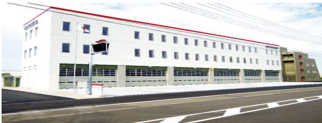
消防本部・岩見沢消防署
