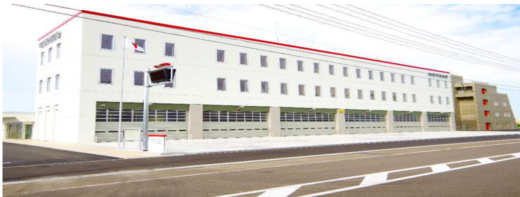
消防本部・岩見沢消防署
